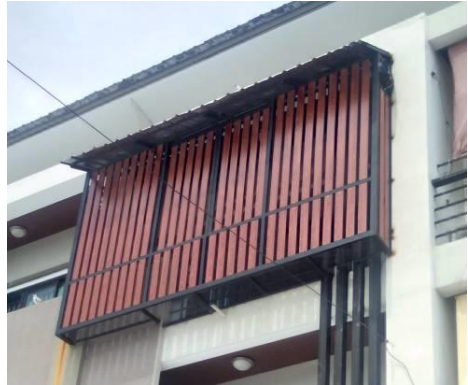
ภาพที่ 16 ชุดแผงกันแดดด้วยหลักการ Passive & Active Mixed Cooling System ที่สมบูรณ์
