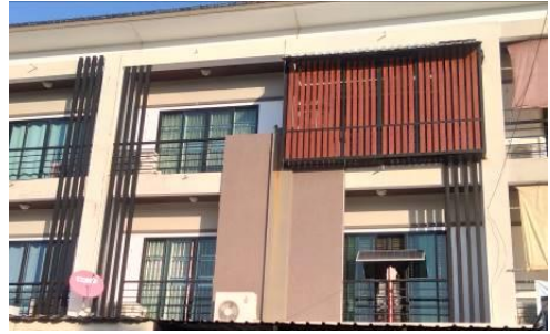
ภาพที่ 17 ชุดแผงกันแดด Passive & Active Mixed Cooling System ที่ติดตั้งเสร็จสมบูรณ์
